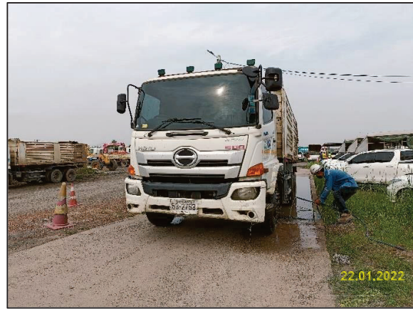
รูปที่ 2-9 การจัดทำพื้นที่ล้างล้อพร้อมทั้งล้างทำความสะอาดเศษดิน และเศษโคลนที่ติดกับล้อรถ ก่อนออกจากพื้นที่เก็บกองท่อ (Stock Yard) และพื้นที่ก่อสร้าง
