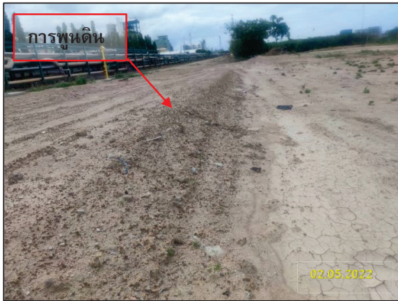
รูปที่ 2-14 การทำพูนดิน (Crown) บริเวณพื้นที่หลังท่อ
