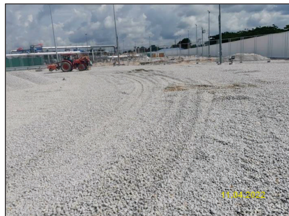
รูปที่ 2-10 การโรยหินกรวดบริเวณทางเข้า-ออกพื้นที่โครงการ
