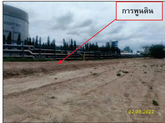
รูปที่ 2-14 การทำพูนดิน (Crown) บริเวณพื้นที่หลังท่อ
