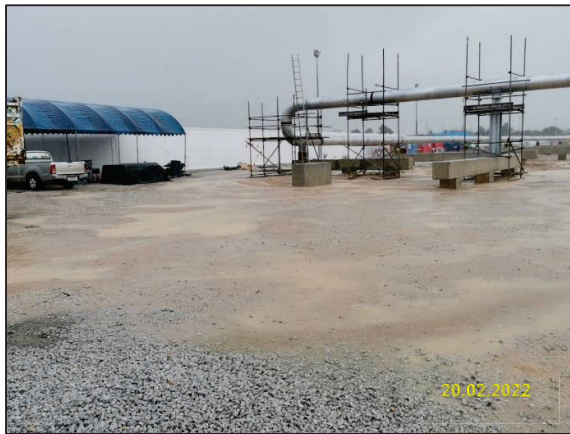
รูปที่ 2-9 การจัดทำพื้นที่ล้างล้อพร้อมทั้งล้างทำความสะอาดเศษดิน และเศษโคลนที่ติดกับล้อรถ ก่อนออกจากพื้นที่เก็บกองท่อ (Stock Yard) และพื้นที่ก่อสร้าง
