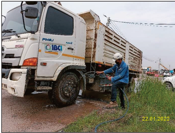
รูปที่ 2-9 การจัดทำพื้นที่ล้างล้อพร้อมทั้งล้างทำความสะอาดเศษดิน และเศษโคลนที่ติดกับล้อรถ ก่อนออกจากพื้นที่เก็บกองท่อ (Stock Yard) และพื้นที่ก่อสร้าง
