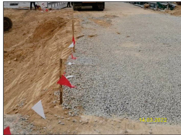
รูปที่ 2-9 การจัดทำพื้นที่ล้างล้อพร้อมทั้งล้างทำความสะอาดเศษดิน และเศษโคลนที่ติดกับล้อรถ ก่อนออกจากพื้นที่เก็บกองท่อ (Stock Yard) และพื้นที่ก่อสร้าง
